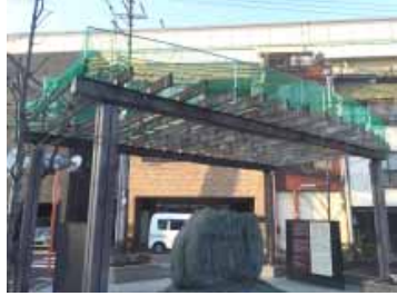
防鳥ネット取付け完了
